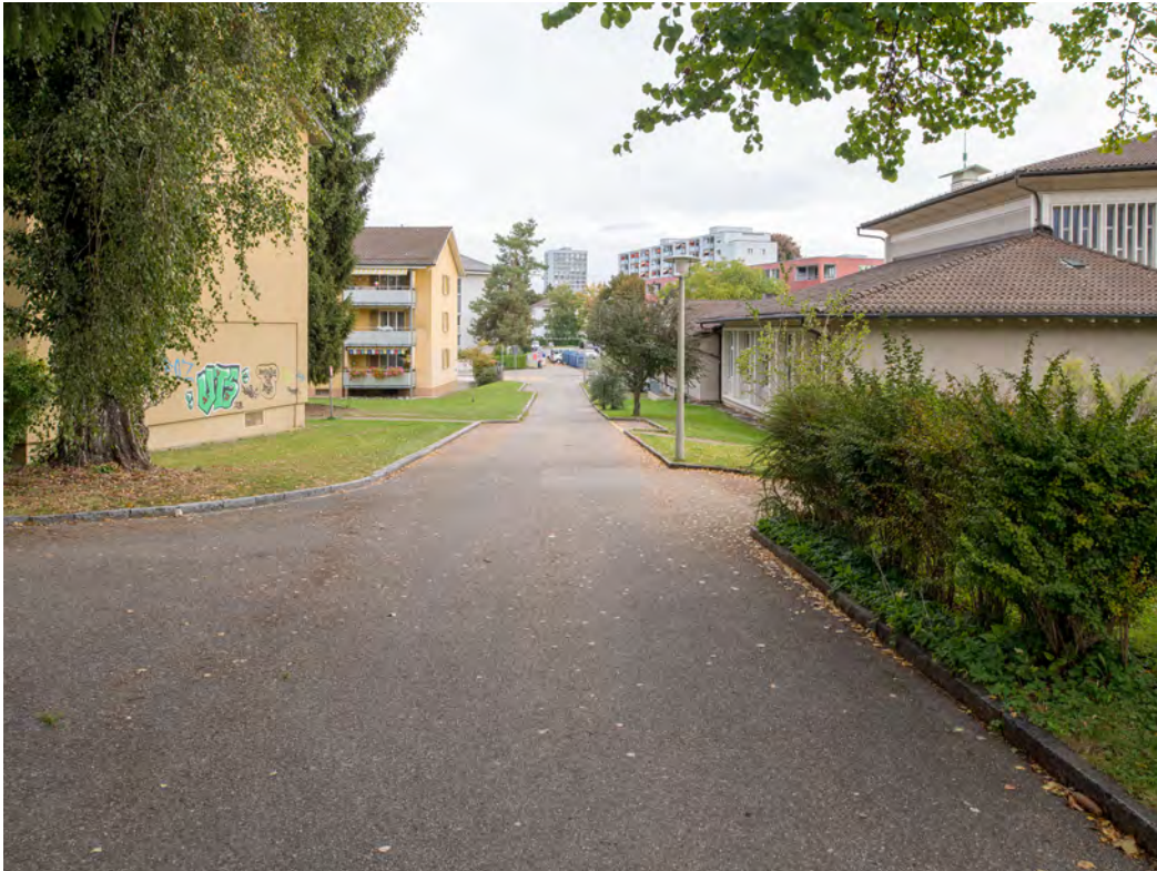
Abb. 8 Luchswiesenweg, Richtung Nord
